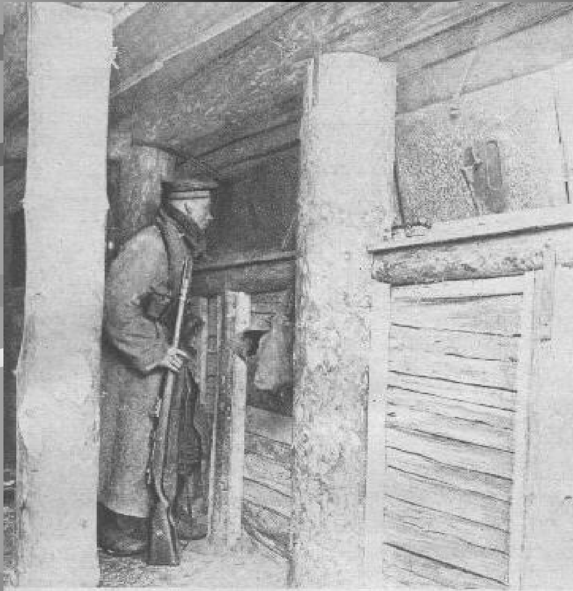
Heberbohle starke Grabenstellung.
